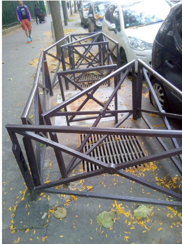
Barrière empêchant de s'installer sur les bouches d'aération du métro parisien.
