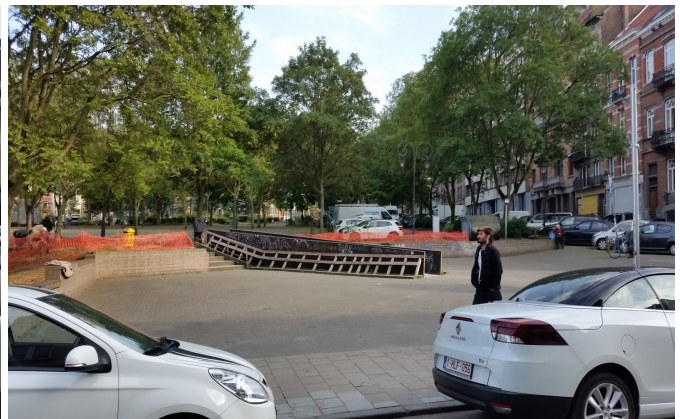
12) Vue depuis la rue Jourdan sur l'espace faisant la jonction avec le parvis avec rampe d'accès PMR rajoutée.
